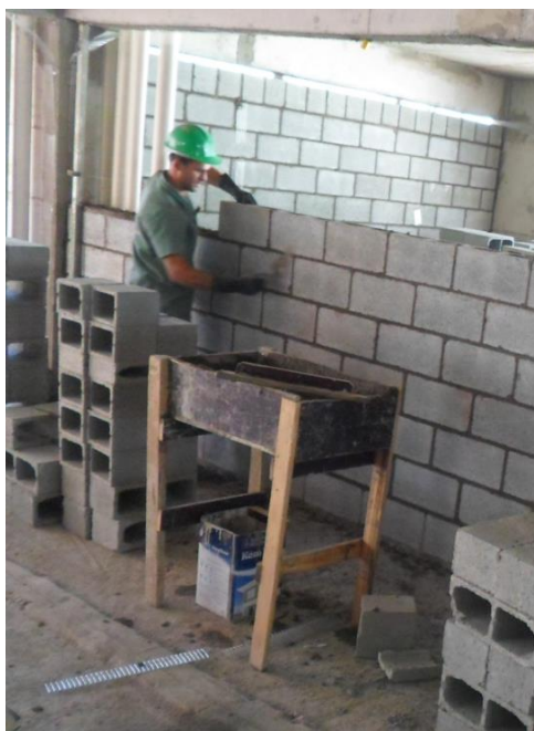
Figura 28 - Assentamento de Blocos com argamassa
